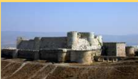
Crac de Chevaliers
